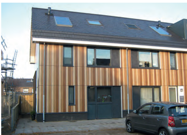
Velve Lindenhof Enschede (2011-2013), gerealiseerd volgens Passief Bouwen, alle woningen hebben een EPC < 0,4 zonder PV-panelen. Ontwerp: Beltman Architecten; realisatie: Te Pas Bouw/DGV.
