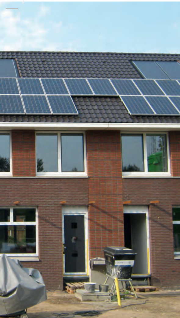
Project Welemanstraat Borne (2012). Met een beperkte hoeveelheid PV-panelen krijgen deze passiefwoningen een EPC van 0. Ontwerp: Beltman Architecten; realisatie: Oude Lenferink Bouw.
