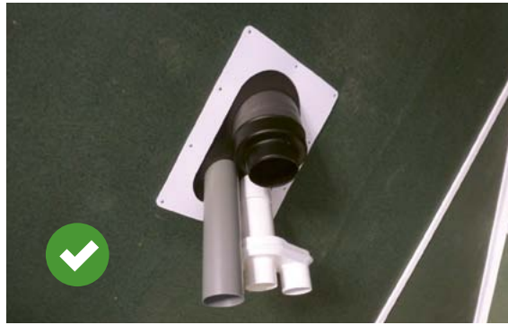
De dakdoorvoeren luchtdicht afgewerkt met een manchet.
