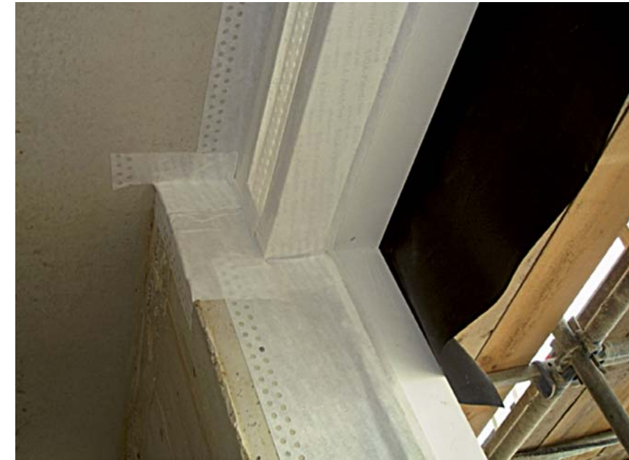
Kozijn aan de binnenzijde luchtdicht afgeplakt.
